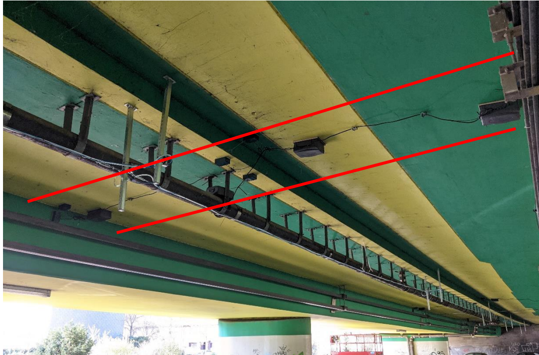
Ansicht des ganzen Profils: linker und rechter Kragarm. Sensormodule und Versorgungsboxen
